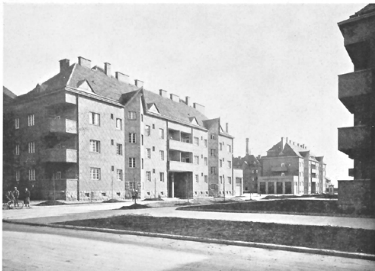
Ansicht der Rotdorn-Allee mit Blick in den „Ulmenhof“. (Entwurf Arch. Baurat R. Oerley.)
