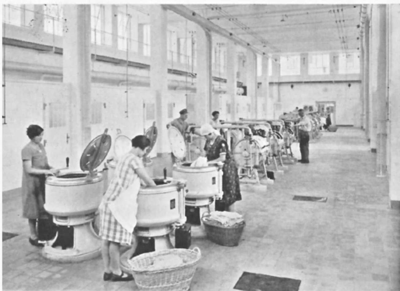
Waschsaal einer der beiden Zentral-Wäschereien. (Entwurf Arch. Baurat R. Oerley.)
