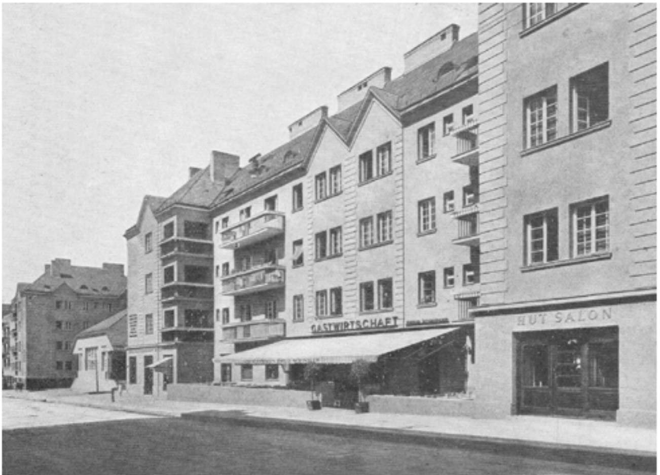
Die Wohnhausanlage XIII., Penzinger Straße—Cumberlandstraße (Ansicht Penzingerstraße)
