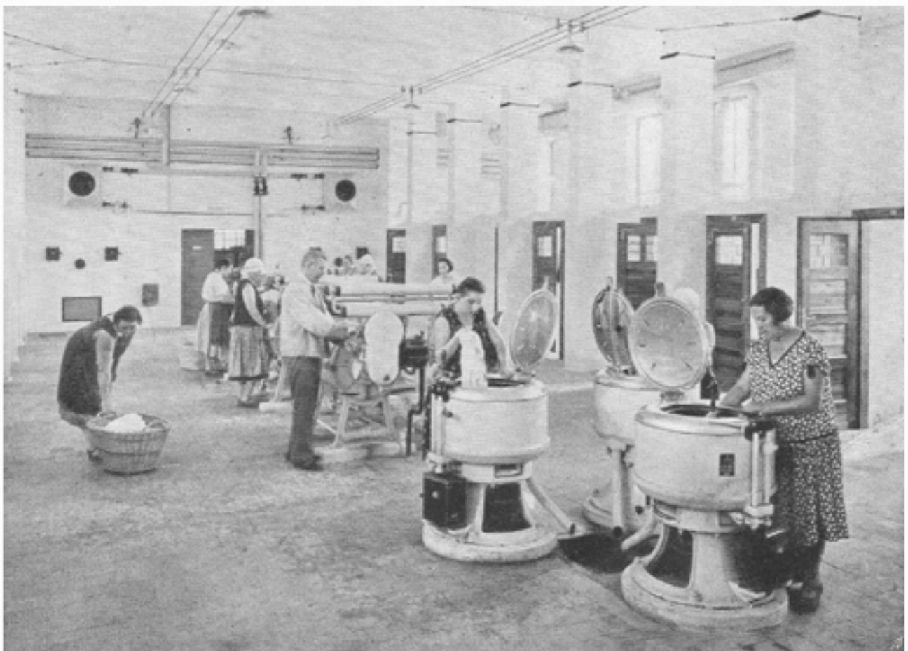
Die Wohnhausanlage XIII., Penzinger Straße—Cumberlandstraße (Blick in den Waschsaal der Zentral-Wäscherei)
