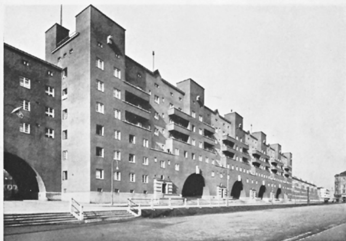
Ansicht der Fassadenfront Boschstraße
