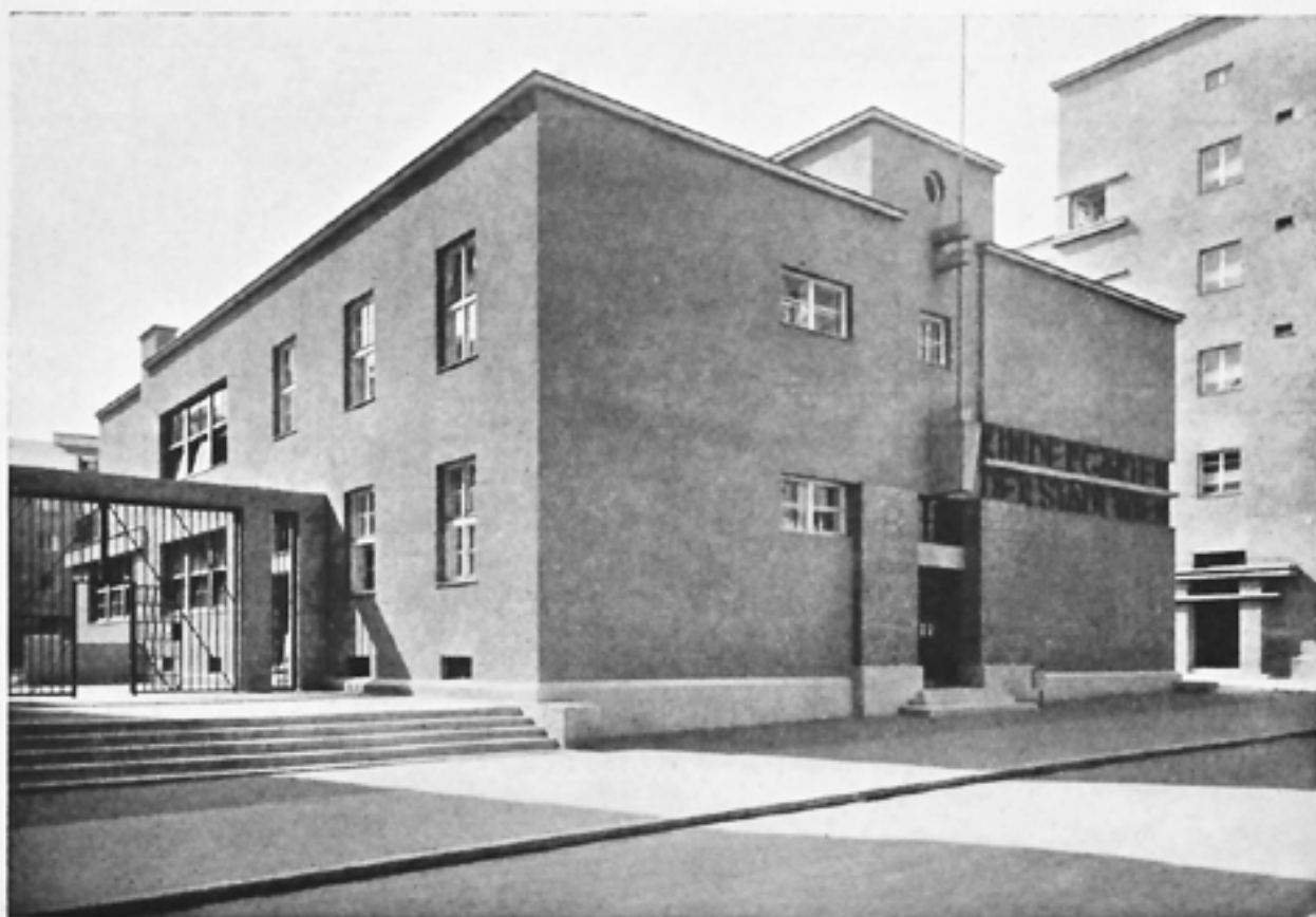
Blick auf den südlich gelegenen Kindergarten
