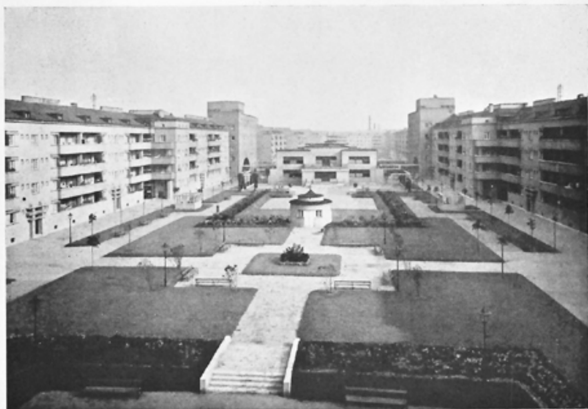
Teilansicht des Gartenhofes mit Kindergarten im Hintergrunde
