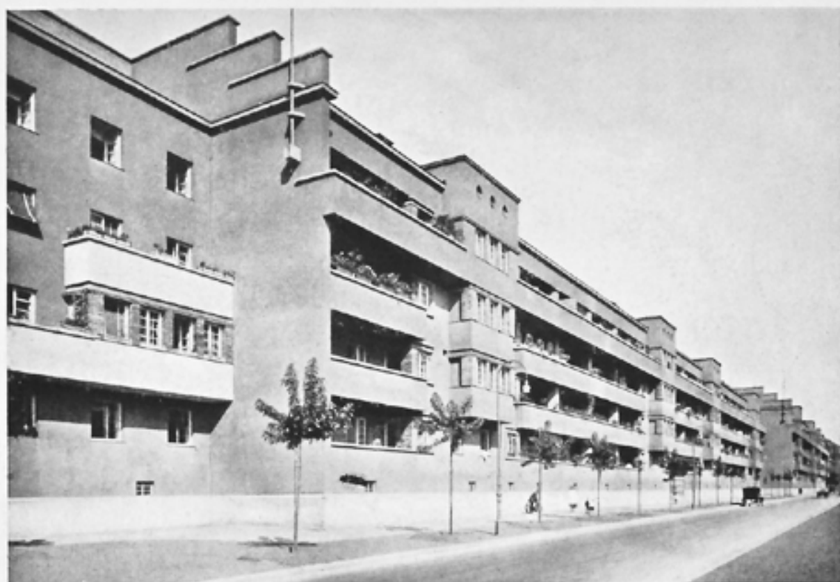
Teilansicht der Fassadenfront Boschstraße
