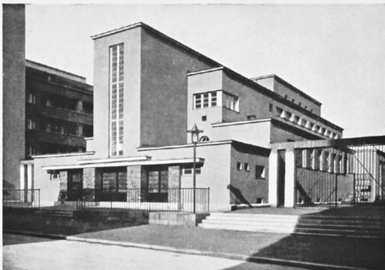
Blick auf die südlich gelegene Wäscherei
