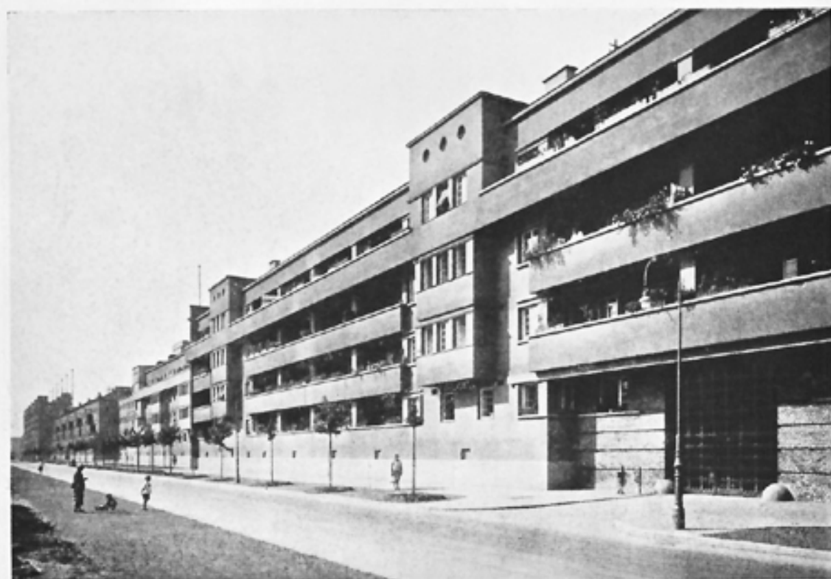
Teilansicht der Fassadenfront Boschstraße
